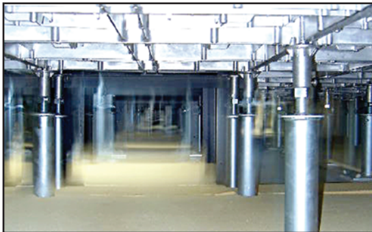
施工例：OAフロア床下断熱 (アイカ工業製接着剤でスラブに貼り付け)
